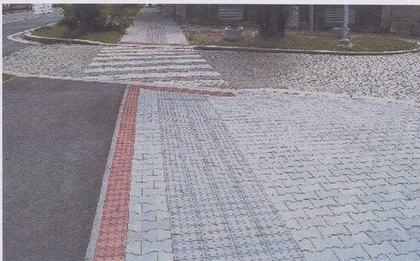
Foto 6: Příklad hmatových úprav z betonových dlažebních bloků se speciální povrchovou úpravou - pravidelné výstupky: - oddělení cyklistické stezky od pruhu pro pěší (0,3 - 0,4 m, barevně kontrastní) - signální pás (0,8 m, barevně nektrastní) - varovný pás (0,4 m, barevně kontrastní)
