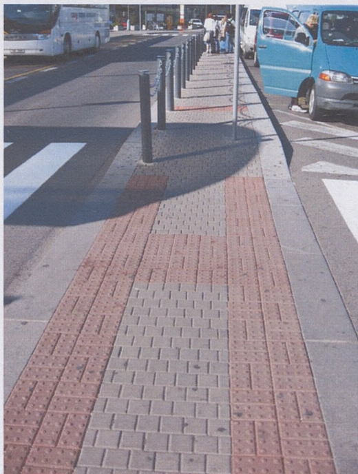
Foto 5: Bezbariérový přechod s úpravami pro nevidomé a slabozraké - varovný a signální pás - speciální dlažba (betonové bloky, povrch s pravidelnými výstupky) - okolní rovinná dlažba - betonové bloky
