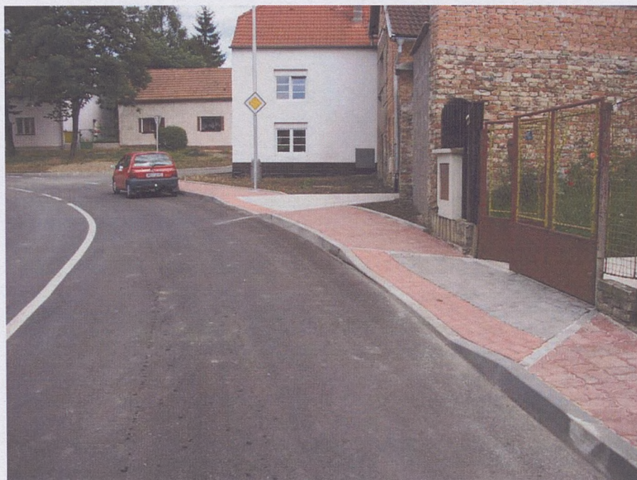
Foto 2: Příklad řešení chodníkového přejezdu - betonová dlažba
