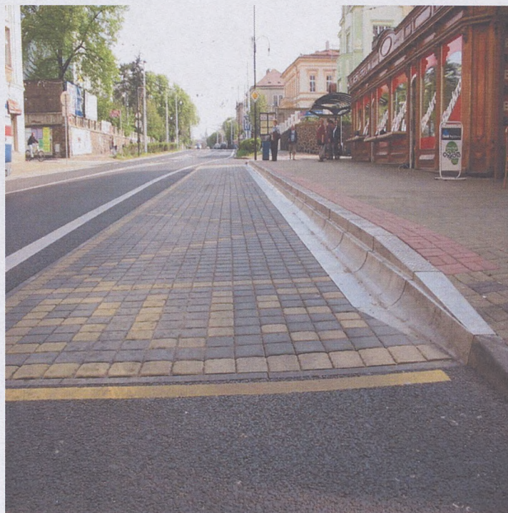
Foto 8: Příklad řešení zastávky veřejné hromadné dopravy s bezbariérovým obrubníkem
